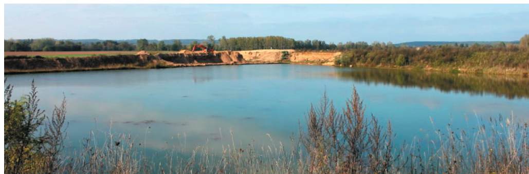
Carrière de La Pierre-Levée, en cours d'exploitation
